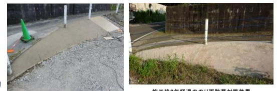
施工後2年経過ののり面防草対策効果
