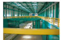
福岡県古賀市・古賀清掃工場
