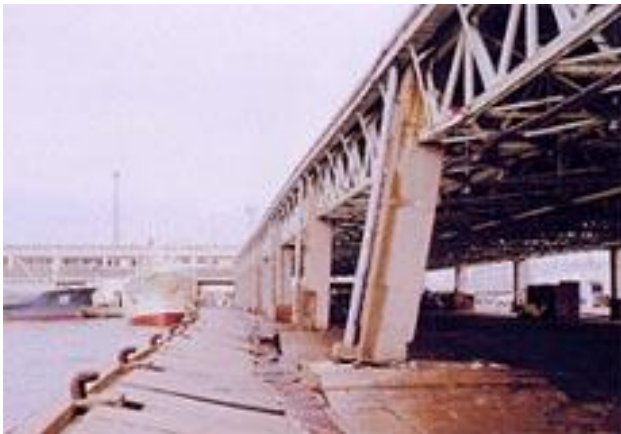
基礎の水平移動に伴う柱の倒れ
