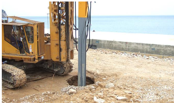
締固め工法 (SCP)
