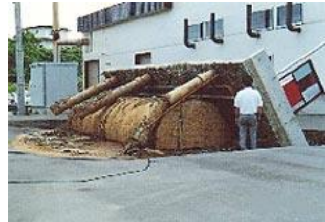
浮力による地下オイルタンクの浮上がり
