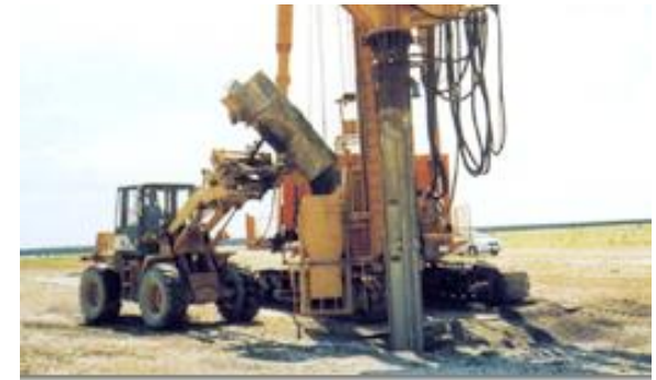
間隙水圧消散工法 (バーチカドレーン)
