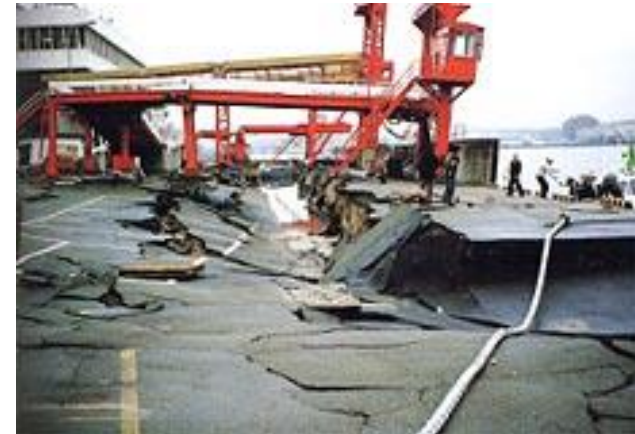
岸壁の裏込め土の流出による地盤沈下
