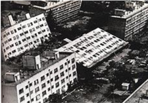
地盤支持力消失によるアパートの転倒
