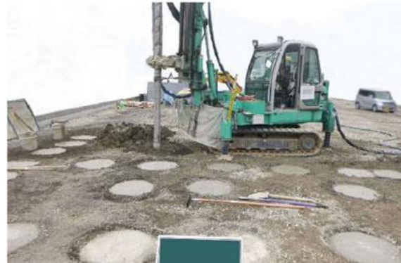
固化工法 (深層混合処理工法)
