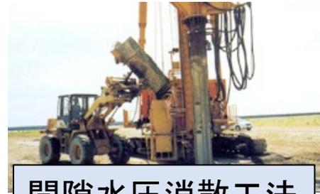
間隙水圧消散工法
