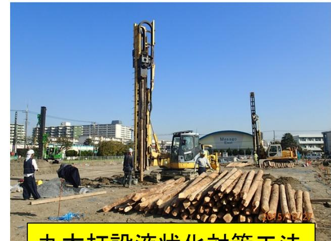
丸太打設液状化対策工法
