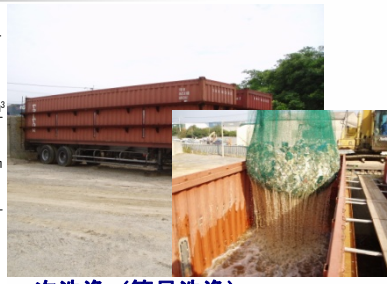
一次洗浄（簡易洗浄）
