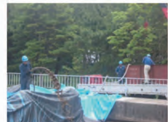
津波被災した下水処理場(左)の硫化水素対策に溶解ダストを投入(右)
