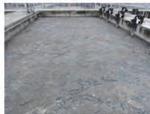
津波被災した下水処理場(左)の硫化水素対策に溶解ダストを投入(右)
