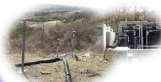
霧状酸化剤による硫化水素、 メタンガス対策実施例 (2007～2010北九州環境未 来助成金)
