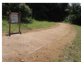
施工直後の状況
